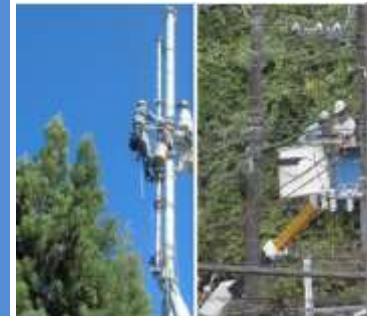
Obras de base de transmissão Manutenção de TV à cabo
